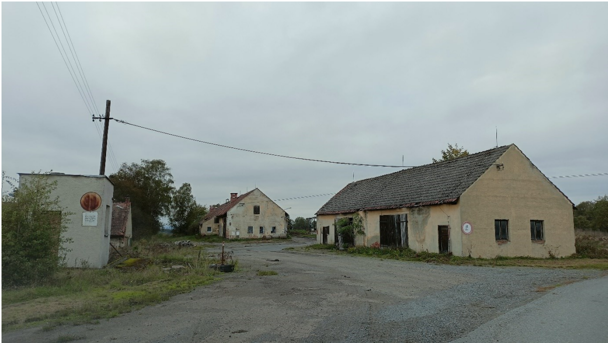
Obrázek 1.1: Rozpadající se budovy JZD na okraji obce.
