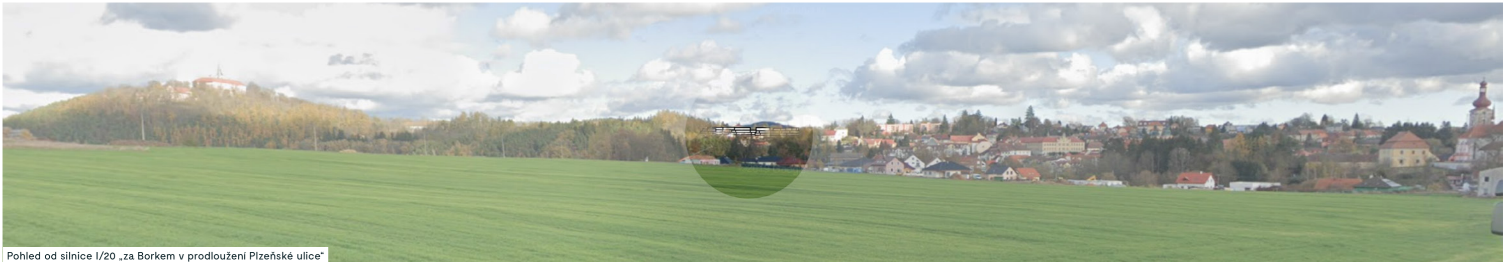
Pohled od silnice I/20 „za Borkem v prodloužení Plzeňské ulice“
