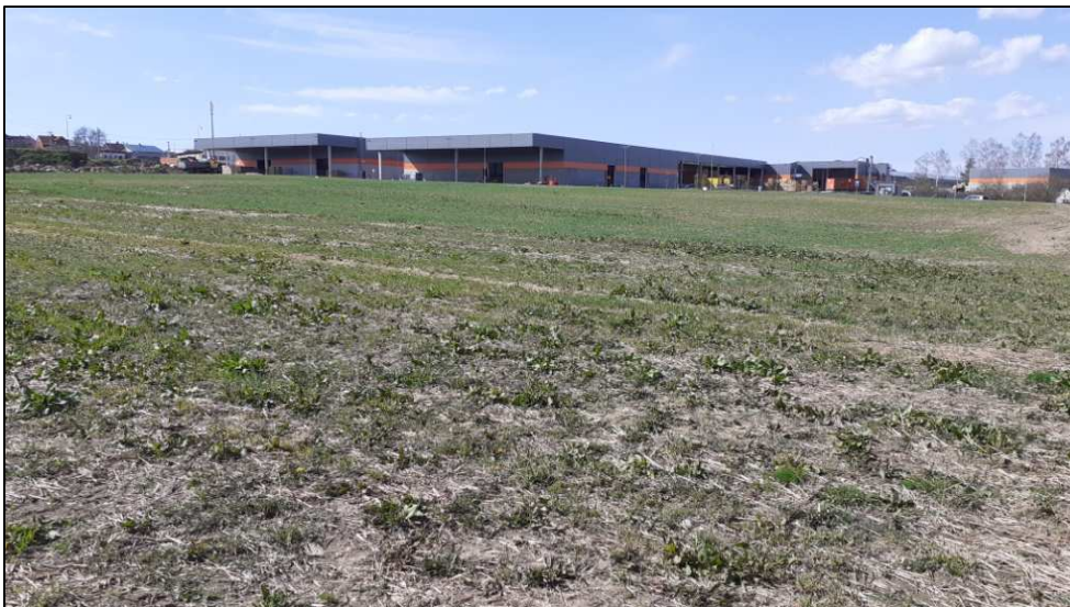
Pohled na stávající výrobní areál KLAUS Timber od jihu
