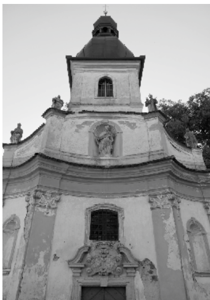
Štít kostela v Nových Mitrovicích
