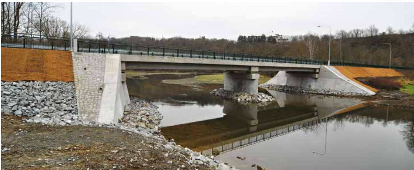
Rekonstrukce mostu mezi Liticemi a Valchou v Plzni byla pro nás velkou výzvou
