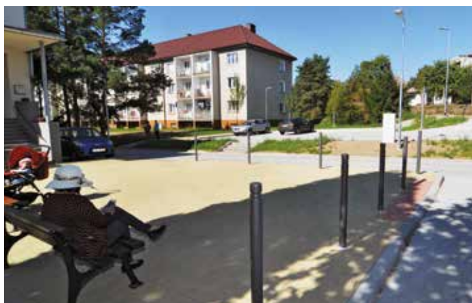
Výstavba parkoviště u MŠ Nepomuk
