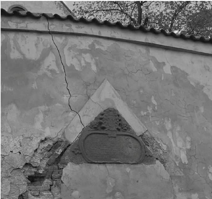
Celková situace zazděného vchodu na západní straně ohradní zdi kostela sv. Jakuba Staršího (foto autor článku).
