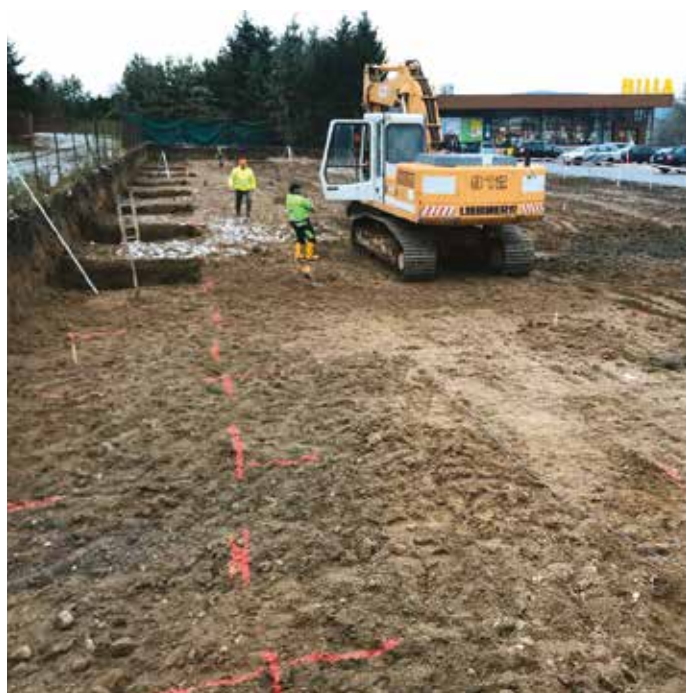
Zahájení prací - leden 2022
