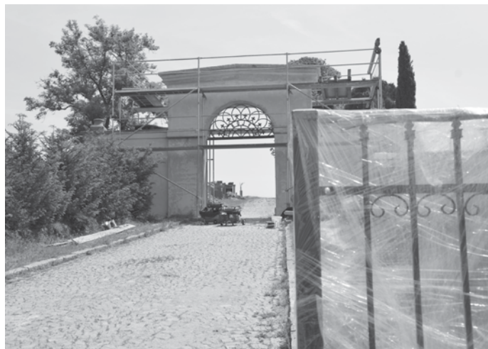
Vstupní brána na hřbitov v průběhu rekonstrukce 16. května, foto Šárka Boušová
