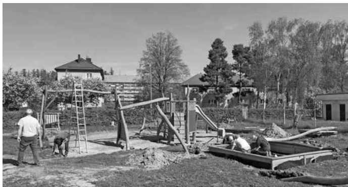
Stavební ruch na hřišti 10. května, foto Marek Baroch
