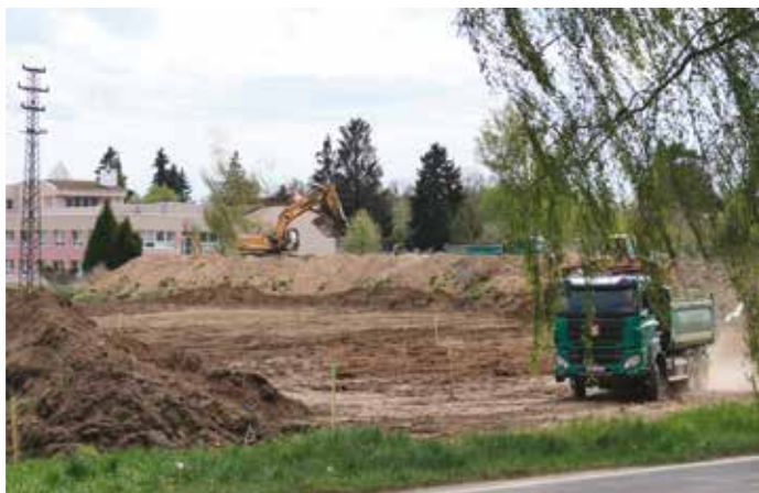
Úprava terénu v lokalitě Pod Vinicí, foto Lukáš Mácha
