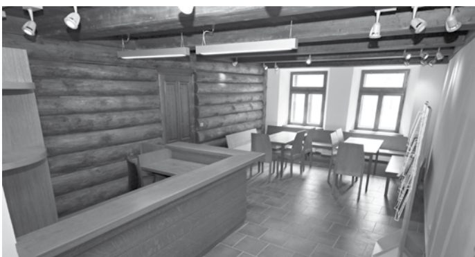
Bývalá světnice, kde se zachovala stěna z roubených klád, ovšem ve velmi špatném stavu. Při rekonstrukci vznikla nová z kulatin. Zde je umístěna recepcce, dnes využívaná jako kancelář. Foto Pavel Jiran
