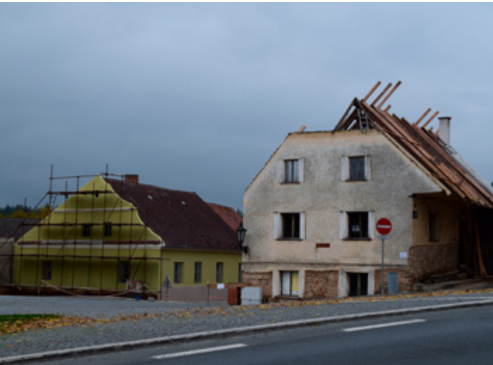
Č. p. 3 a č. p. 179 (vpravo) během oprav
