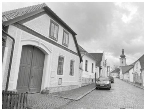
Nejeden z domů v Plzeňské ulici byl v posledních letech opraven s přispěním městského dotačního programu.
