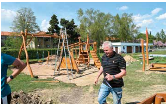
Stavba dětského hřiště u školy v květnu 2022
