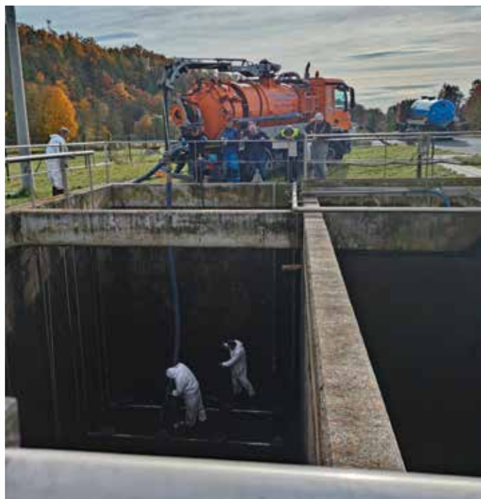
Čištění akivačních nádrží a výměna provzdušňovacích elementů na ČOV Nezvěstice
