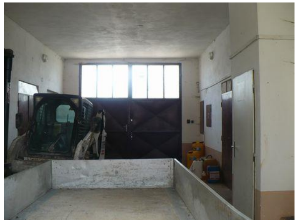
průjezd v budově na p.č.127/4
